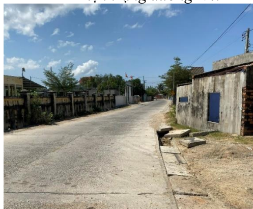
Hiện trạng đường bê tông xi măng
