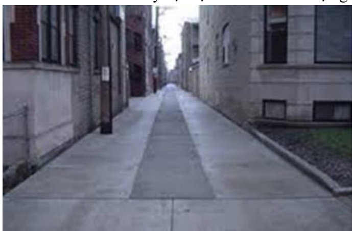
Hình 57 - Nhựa đường thấm nước ở giữa hẻm (Chicago)
