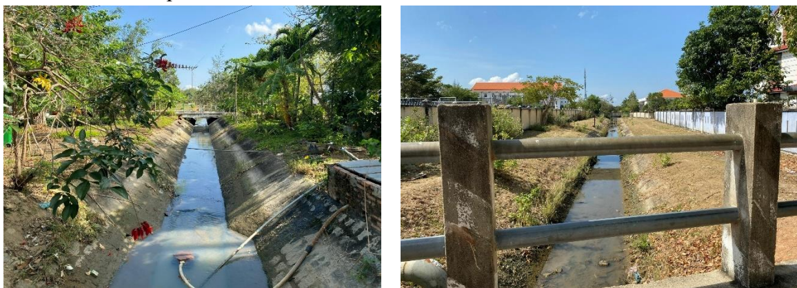
Hiện trạng mương thoát nước
